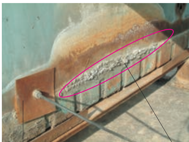
رسوب‌های آب تعمیر غیراساسی شکل ۸-۱۷۶
