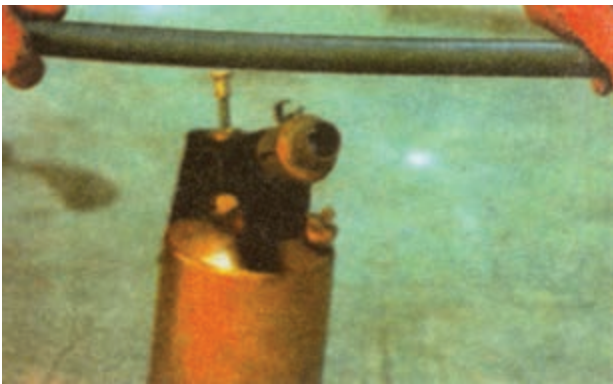
شکل ۴-۴۳- حرارت دادن لوله ی PVC
