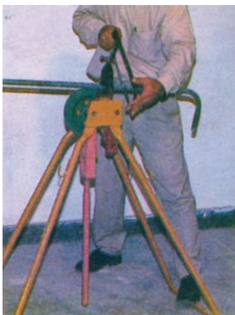
الف- بریدن لوله توسط اره
