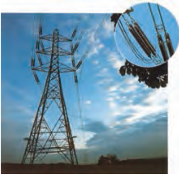
شکل ۳-۱۹- سیم های رابط خطوط انتقال باید دارای مقاومت کمی باشند. مقاومت این سیم ها از نوع مقاومت های مزاحم است.
