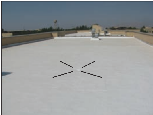
شکل ۱۱-۶ سطح پشت بام
