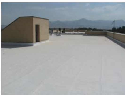
شکل ۱۲-۶ سطح پشت بام
