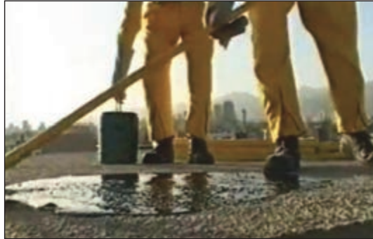
شکل ۲۲-۶ قیرگونی پس از پرکردن بین کُرْم‌ها
