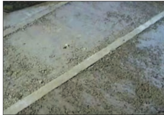
شکل ۲۱-۶ پرکردن فضای بین کرم‌ها با پوکمه معدنی
