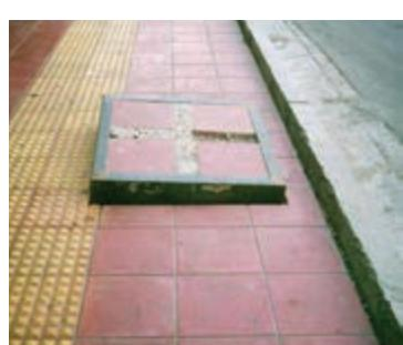
◀ شکل ۳-۵۶ رویه نهایی معابر با موزاییک آجر در مناطق معتدل خشک و گرمسیر بسیار مناسب است (شکل ۳-۵۷).
