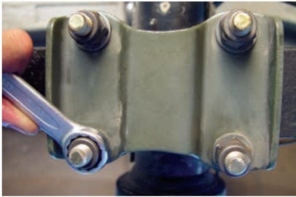
شکل ۳-۶۶- باز کردن مهره‌های کرپی‌ها (پیچ‌های U شکل)
