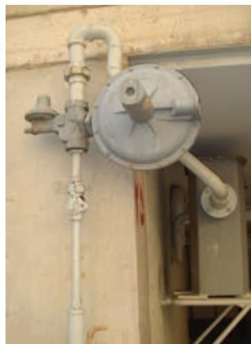
و رگولاتور روی آن و شکل ۲-۹۴، مقطع یک علمک و رگولاتور نصب شده بر روی آن را نشان می‌دهد.
