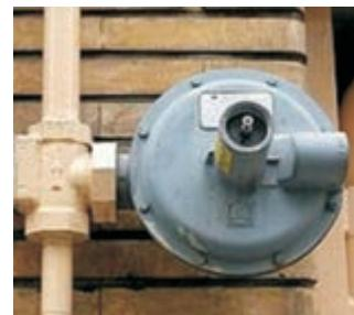
**هشدار :** رگولاتور در گازرسانی خانگی، یک وسیله ایمنی و محافظت در استفاده از انرژی پاک و دور از آلودگی است. از تعمیر رگولاتور به وسیله افراد غیرمتخصص، جداً خودداری نمایید.
