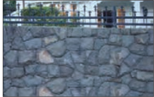
شکل ۱-۱۹۶ دیوار با سنگ کوهی چندوجهی نامنظم سرتراش بدون رج
