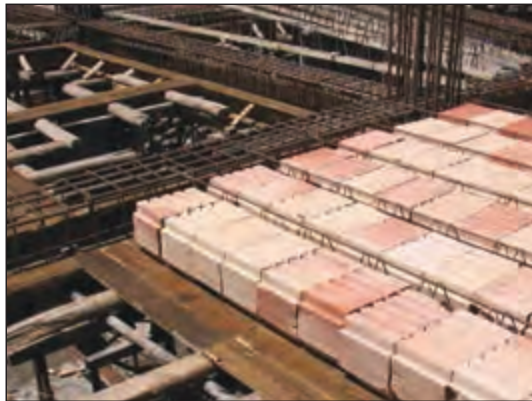
شکل ۱-۱۵۲ کاربرد بلوک سفالی در سقف
