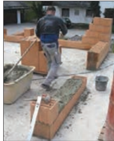
شکل ۱-۱۵۳ ساخت دیوار با بلوک سفالی
