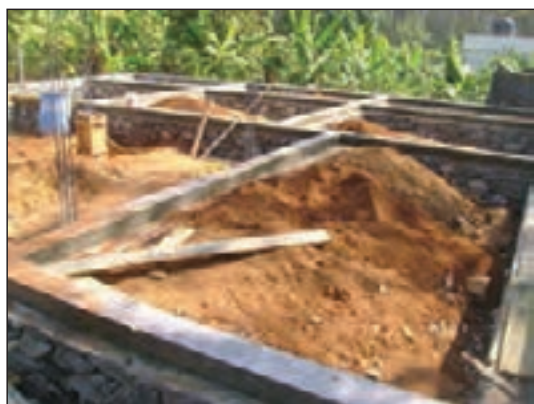
شکل ۲۰۵-۱ بتن ریزی کلاف بندی افقی تحتانی
