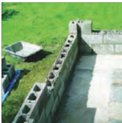
شکل ۱۵۰- ساخت دیوار با بلوک‌های بتنی یا سیمانی
