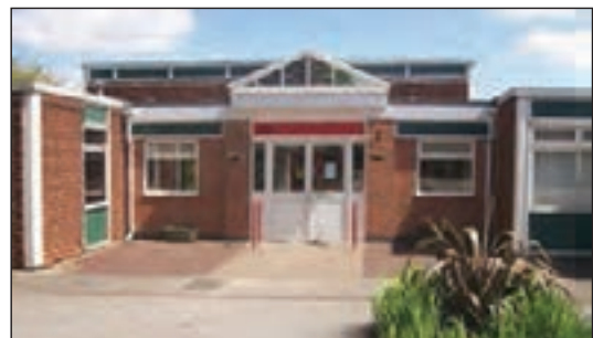
شکل ۱۳۳-۱ دیوار با نمای آجری
