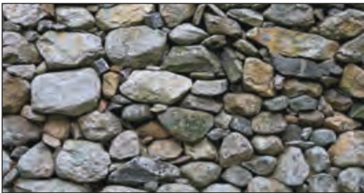
شکل ۱۳۶- دیوار سنگی خشکه چین
