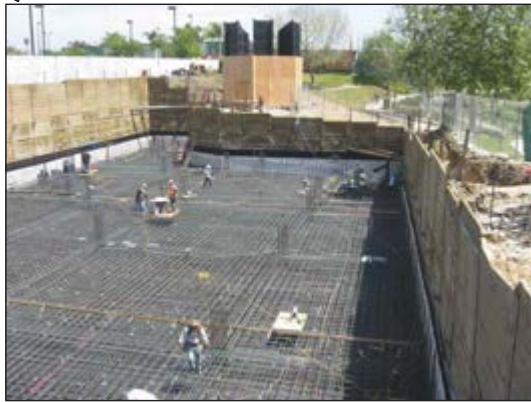
شکل ۱-۶۲ پی بتن مسلح یکپارچه (رادیه ژنرال)
