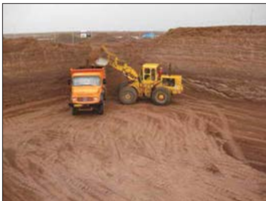
شکل ۸۵-۱ گودبرداری با لودر در زمین نامحدود
