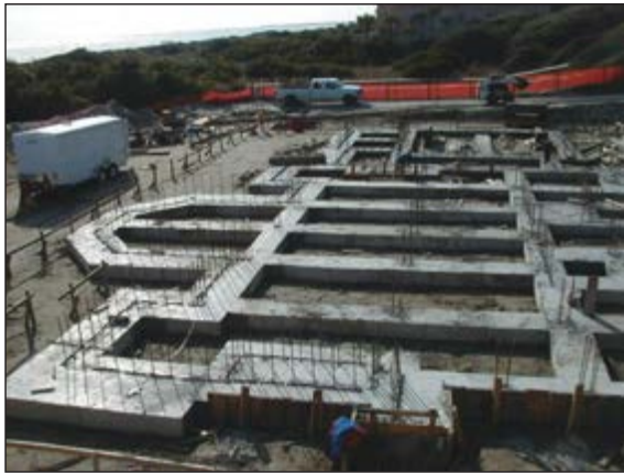
شکل ۱-۵۶ پی بتن مسلح نواری شبکه ای زیرستون
