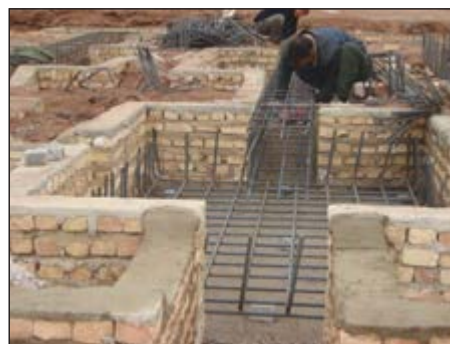
شکل ۱-۸۲ قالب‌بندی آجری در اطراف پی
