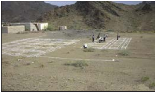
شکل ۸۳-۱ پیاده کردن نقشه روی زمین
