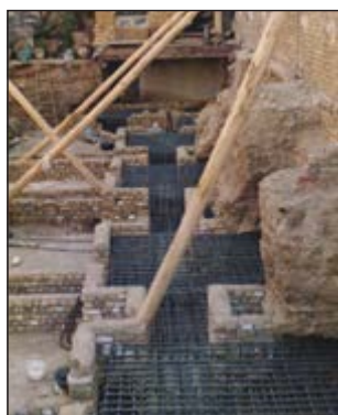
شکل ۹۰-۱ مهاربندی با شمع چوبی
