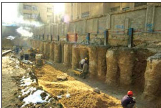
شکل ۸۸-۱ مهاربندی با پشت بند خاکی ستونی
