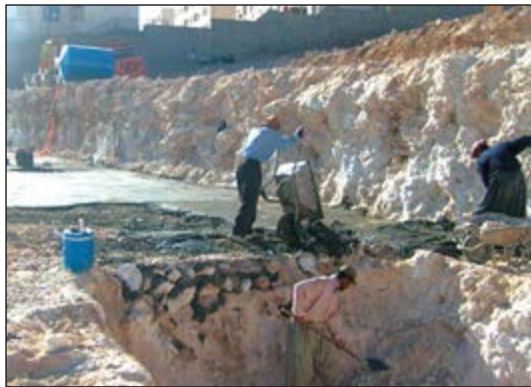
شکل ۸۷-۱ گودبرداری دستی (با بیل و کلنگ)
