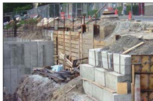
شکل ۹۱-۱ مهاربندی با دیوار مانع چوبی
