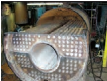
شکل ۴۲-۱ لوله‌ی چدنی دیگ بخار
