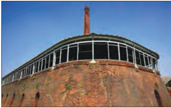
شکل ۶۳-۱ نمایی از کوره هوفمان
