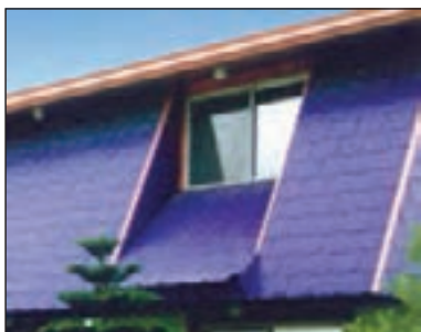
شکل ۴۷-۱ پوشش نهایی سقف شیب‌دار با آردواز
