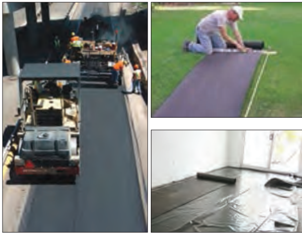
شکل ۴۴-۱ کاربرد قیر در آسفالت کاری و ایزوگام
