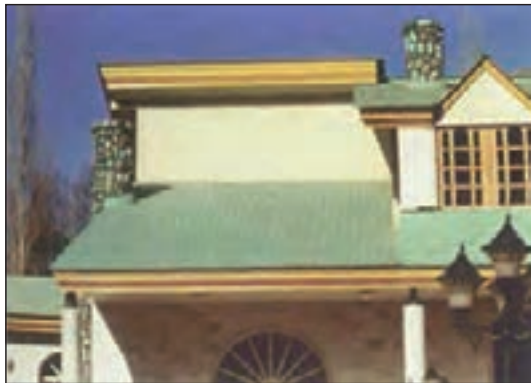
شکل ۱-۱۰۲ پوشش سقف با ورق‌های فشرده‌ی آردواز
