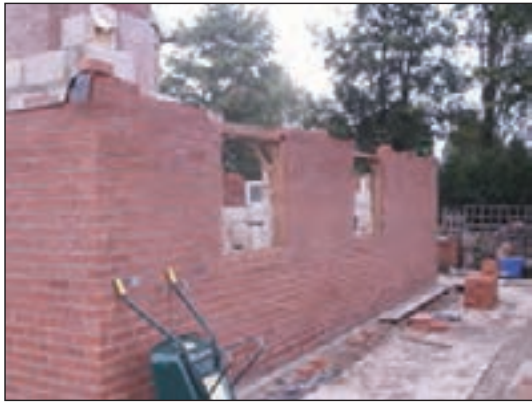
شکل ۱-۱۰۷ دیوار باربر آجری
