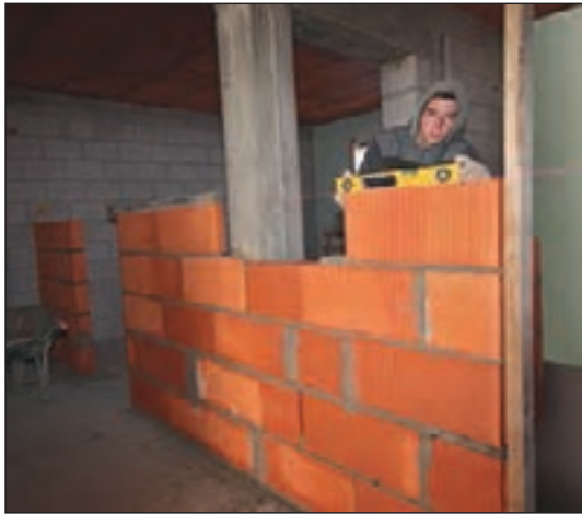
شکل ۱-۱۰۹ دیوار غیرباربر بلوک سفالی
