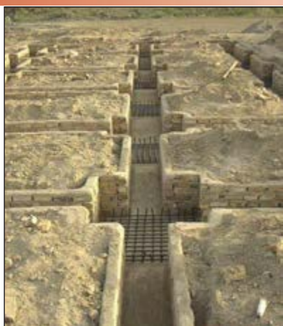
شکل ۴۸-۱ آرماتورگذاری پی تکی کلاف بندی شده
