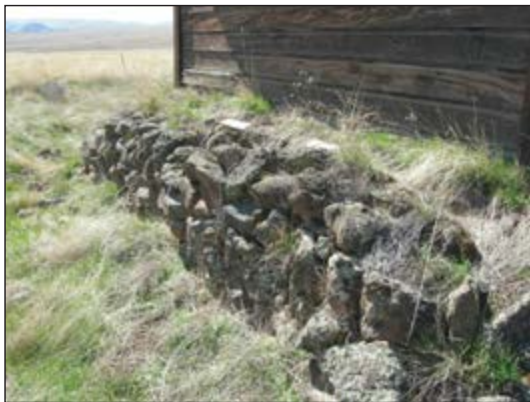
شکل ۱-۳۲ پی سنگی با سنگ لاشه
