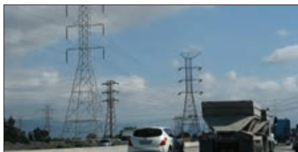
▲ شکل ۱-۵- انتقال انرژی الکتریکی توسط دکل‌ها
