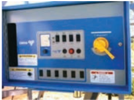
شکل ۷۱-۷- تابلو کنترل دستگاه سنتریوت
