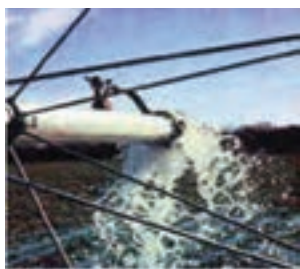
ج) تخلیه آب از انتهای لوله
