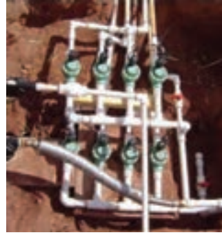
الف) نصب شیرهای برقی در زیر دریاچه در زمین
