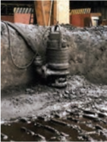
شکل ۹-۵- نصب پمپ کف کش در چاله
