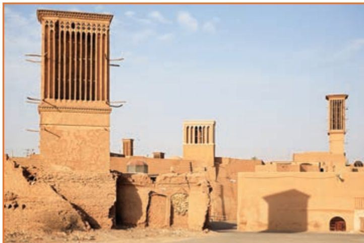
شکل ۸-۲- خانه‌های خشت و گلی همراه با بادگیر
