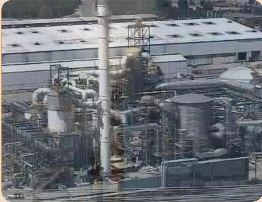
شکل ۶۲-۱- کارخانه اسیدسولفوریک سرچشمه
