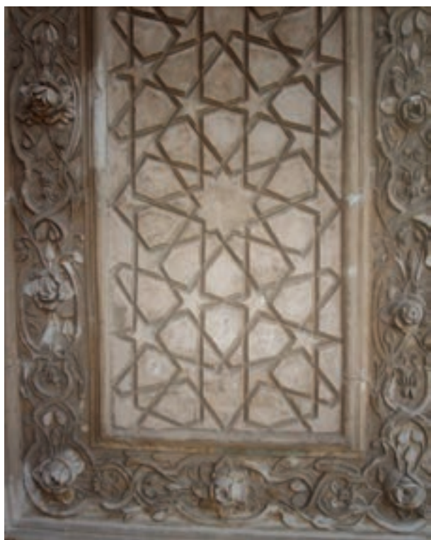
شکل ۶۲-۳- گره تند دو پنج (ده توند) آرامگاه آقا - دوره قاجاریه، بخشی از گچ‌بری دیوار - تهران
