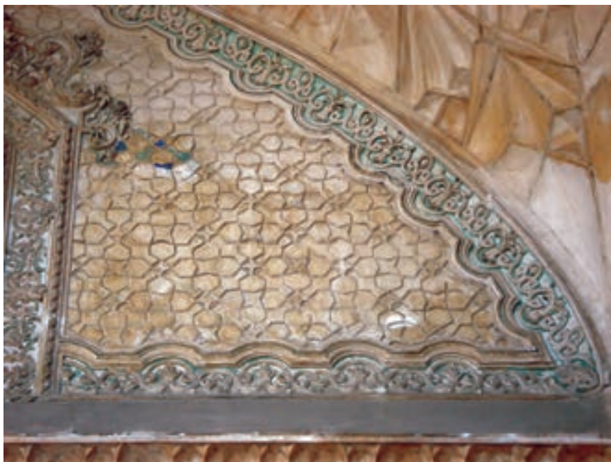
شکل ۲-۲۳- نقش موج و سیلی، گچ‌بری بخشی از دیوار خارجی آرامگاه آقا - تهران
