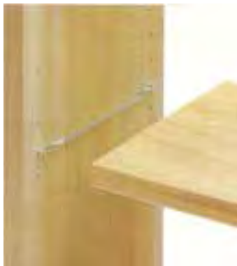
شکل ۲-۴۴- تصویر مجسم اتصال طبقه به وسیله میله فرم داده شده (خم شده)
