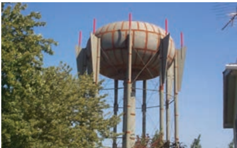
شکل ۷-۱۳- منبع آب از جنس فولاد کربنی در محل خط جوشها دچار زنگ زدگی شده است.
