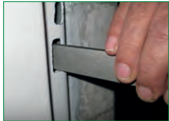
شکل ۱-۴ سوهان کاری سوراخ چهارچوب درب
