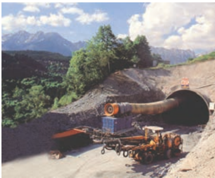
۱۴-۹- لوله‌های فلزی تهویه با اتصال جوشکاری شده
