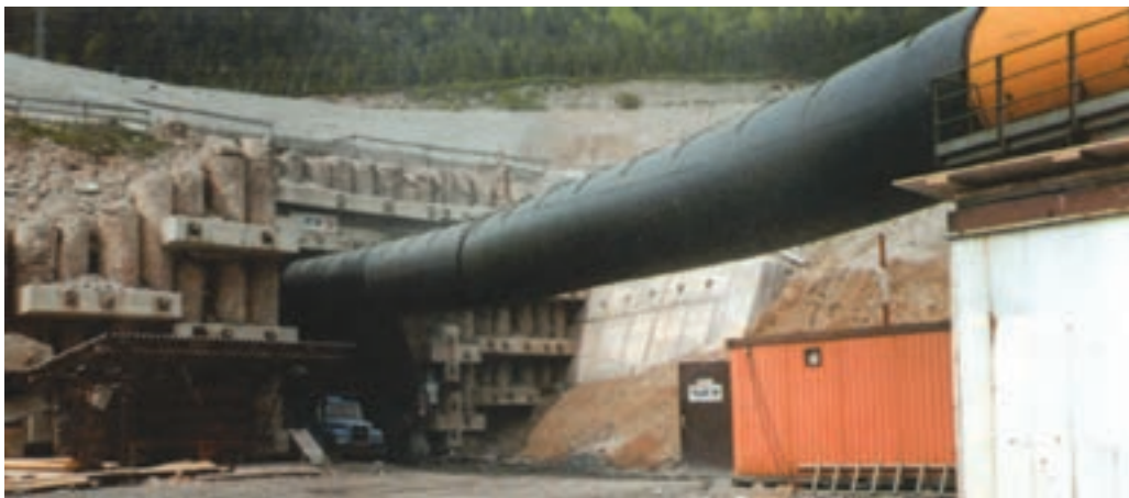
شکل ۱۳-۹- آویز جهت نصب لوله‌های تهویه
