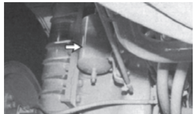
شکل ۴۰-۶- تخلیه آب و رسوبات موجود در مخزن رطوبت
