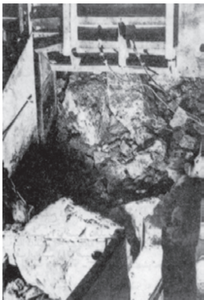
شکل ۳-۴- نحوه‌ی خرد کردن سنگ‌های بزرگ آسبست
