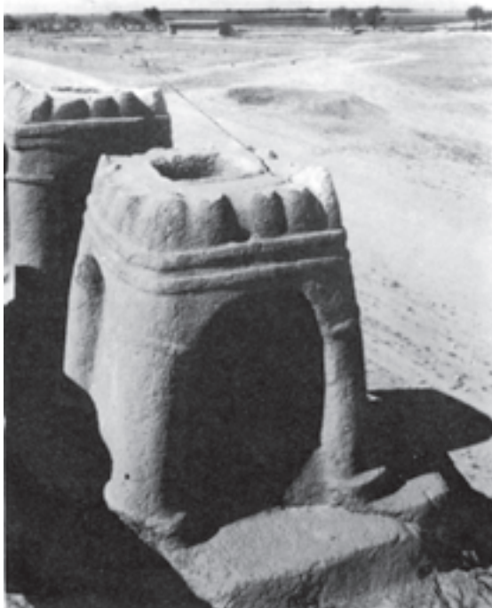
شکل ۱-۱۰- ساختمان آتشکده‌ای در نزدیکی تخت جمشید، نمونه‌ای از فرآیند هوازدگی است.
