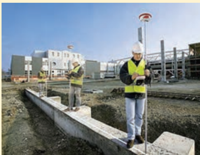
تهیه نقشه با GPS به روش RTK
