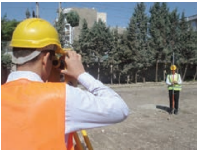
▲ شکل ۴-۳- برداشت زاویه و ژیزمان یک امتداد
