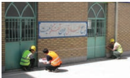
شکل ۲-۵. تهیه‌ی کروکی با متر
