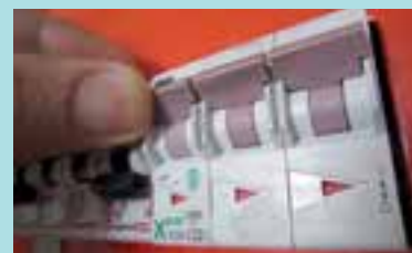
شکل ۵-۶۱ وصل هم‌زمان سه فیوز در مدارهای راه‌اندازی موتورهای سه‌فاز
