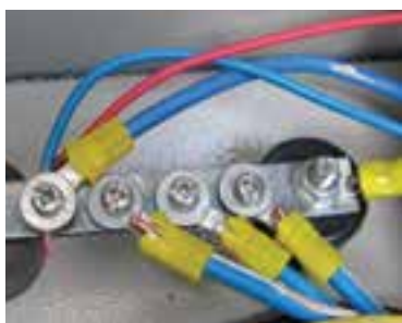
شکل ۳-۱۵ اتصال پیچی.
