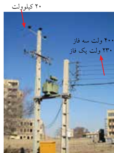
شکل ۱-۷ تبدیل ولتاژ ۲۰ کیلوولت به ۴۰۰ و ۲۳۰ ولت.
