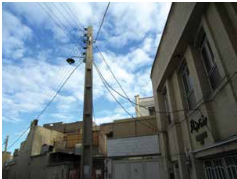
شکل ۱-۹ چگونگی اتصال برق منازل مسکونی.
