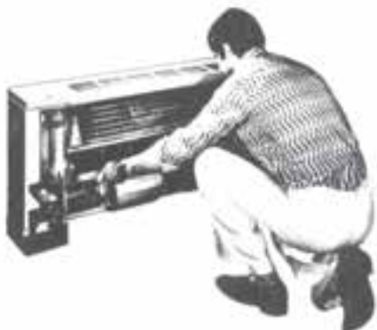
شکل ۱۰-۵- خارج نمودن مجموعه‌ی تشتک، الکتروموتور و ونتیلاتور
