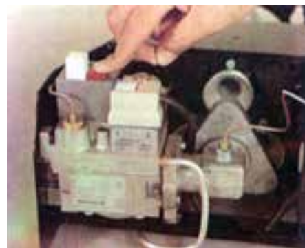
شکل ۳۴-۵ - خاموش کردن دائم مشعل
