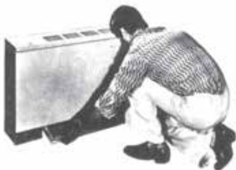
شکل ۹-۵- درآوردن فیلتر فن کویل
