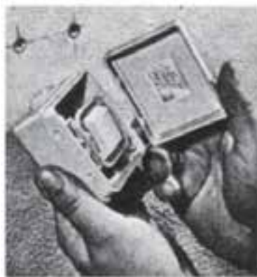
شکل ۵-۳۲- مراحل چگونگی نصب کلید روکار
