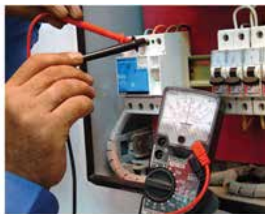
شکل ۹-۱۷- مونتاژ و تست تابلو
