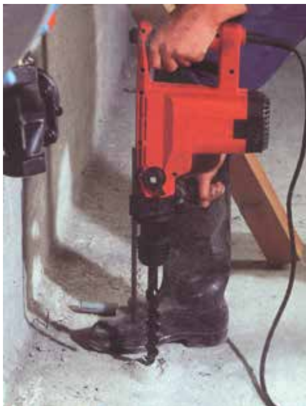
شکل ۵-۱۶- استفاده از کفش مناسب در حال کار
