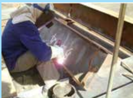
جوش طولی به روش دستی
