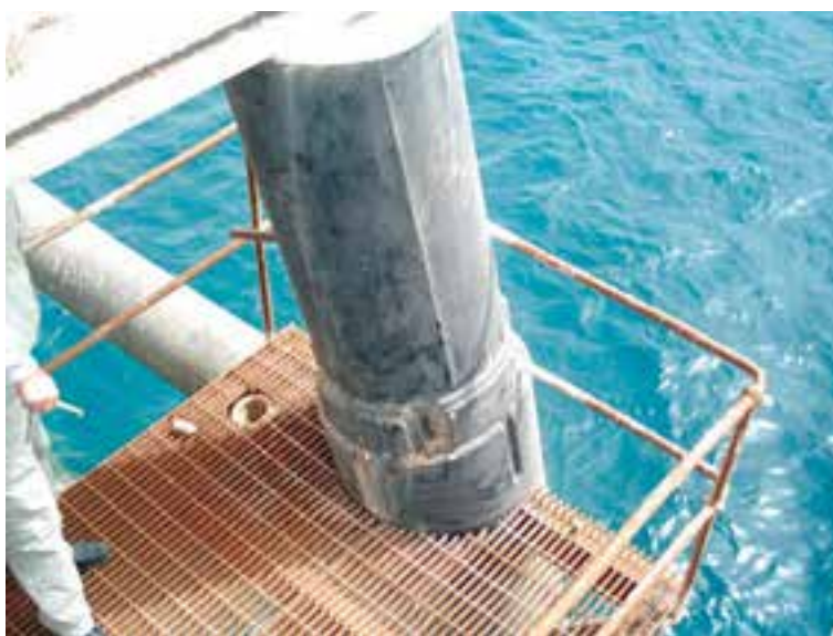
استفاده از پوشش قیری در سازه دریایی
