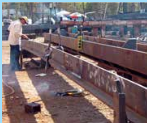
مونتاژ وجوه سوم و چهارم در روش مونتاژ تک مرحله‌ای ستون‌های صلیبی
