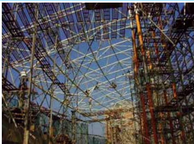
شکل ۱۰-۱۷- نمونه‌ای از سازه با فرپای فضاکار
