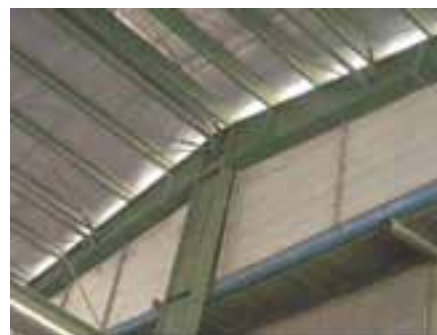
شکل ۱۰-۳۱- اجرای مهاربند افقی در قاب شیبدار
