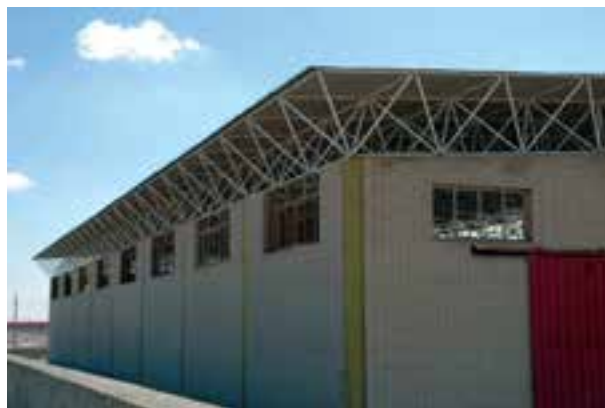
شکل ۱۸-۱۰- نمونه‌ای از خرپای فضایی
