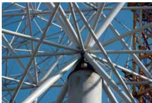
شکل ۲۰-۱۰- نمونه‌ی اتصال اعضای خرپای فضاکار
