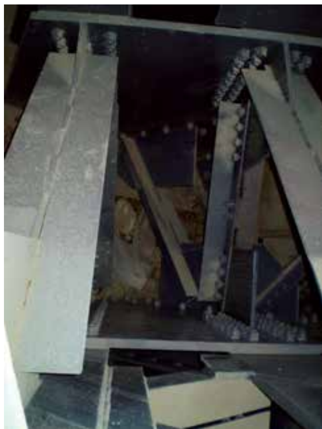
شکل ۱۰-۶ - اتصال پیچ و مهره‌ای اعضای خرپاها
