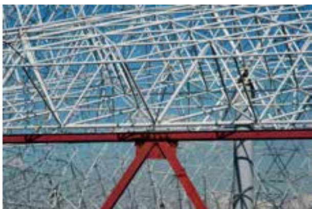
شکل ۲۰-۱۰- نمونه‌ی اتصال اعضای خرپای فضاکار
