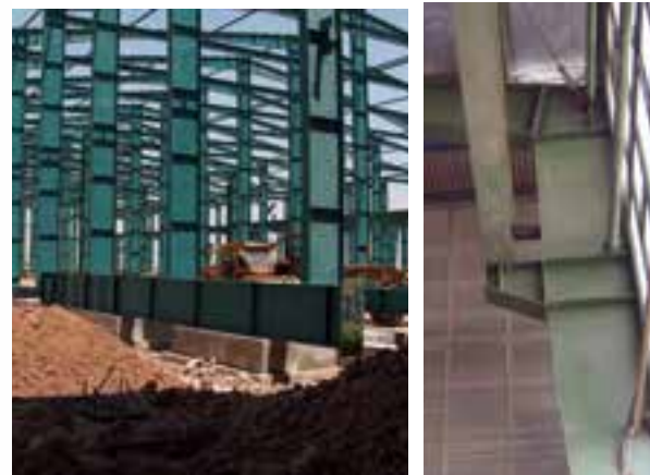
فلنج انتظار در ساختمان صنعتی
