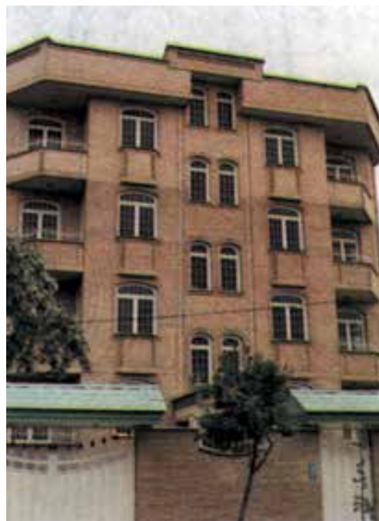
شکل ۶-۱۰- اجرای قوس در نمای آجری
