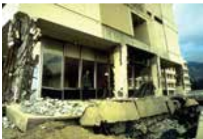
تخریب ستون‌های سازه به دلیل کیفیت نامرغوب بتن و اجرای نادرست آن
