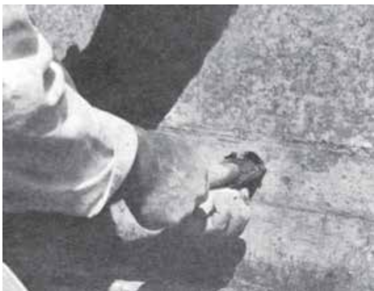
شکل ۶-۳۶- سنبه زدن ملات به داخل سوراخ گیره ی قالب
