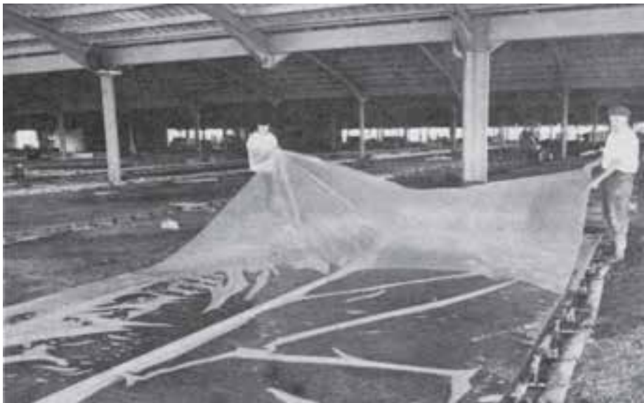
شکل ۶-۳۳- قرار دادن نایلون برای عمل آوردن دال کف
