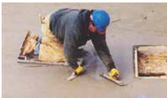
شکل ۶-۲۸- پرداخت نهایی با ابزار دستی
