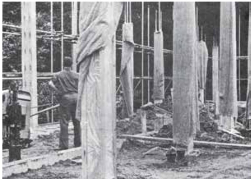
شکل ۳۱-۶- ستون‌های بتنی با نایلون و گونی مرطوب با دقت زیاد عمل آورده می‌شود. دقت کنید که گونی‌ها چگونه از بالای ستون‌ها ریسمان‌پیچی شده‌اند. تمام لبه‌های ستون‌ها با چوب محافظت شده است تا آسیبی به آن‌ها نرسد.
