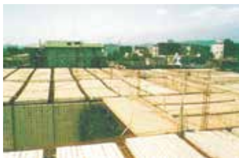
نصب صفحات سقف
