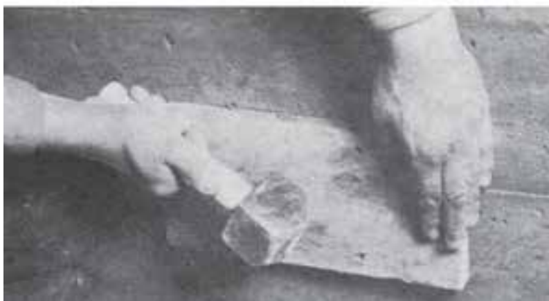
متراکم کردن با یک تخته و چکش
