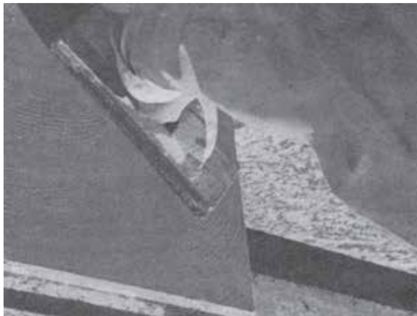
شکل ۶-۳۸- پر کردن جاب‌های سطحی با استفاده از یک ماله با سطح اسفنجی. هنگامی که دوغاب سخت شد، مواد اضافی با مالیدن سطح برداشته می‌شود تا سطح اولیه ظاهر شود.
