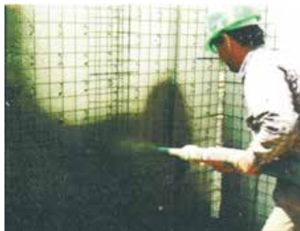
بتن پاشی روی دیوار
