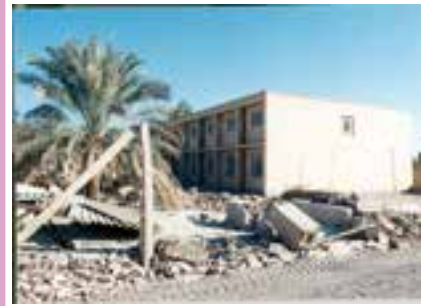
تخریب تیر برق که می تواند علاوه بر قطع برق پس از زلزله، موجب خسارت هایی از قبیل آتش سوزی و ... شود.
