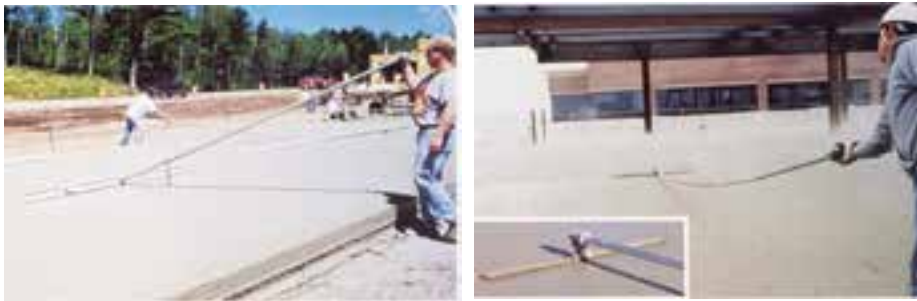
شکل ۶-۲۶- تخته ماله کشی با تخته ماله دسته بلند
