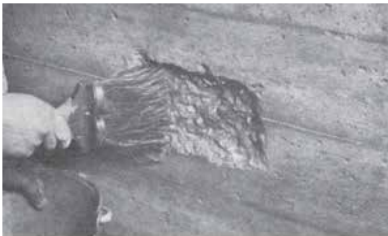
وصله زدن - قسمت معیوب کنده شده و سطح برای جلوگیری از مکش مرطوب می شود.
