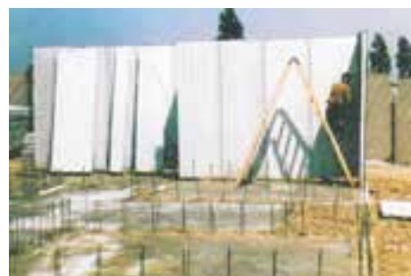
نصب صفحات بر روی فونداسیون اجرا شده
