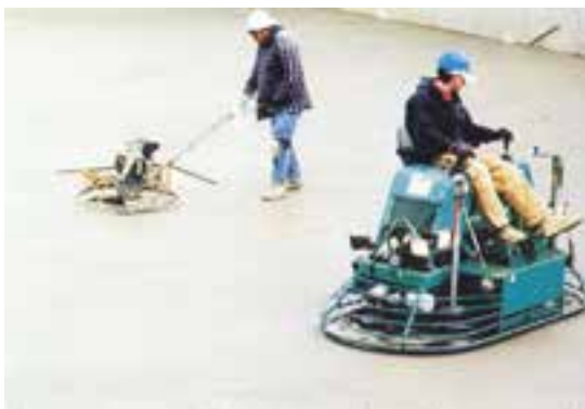
شکل ۶-۲۹- پرداخت نهایی با ابزار مکانیکی
