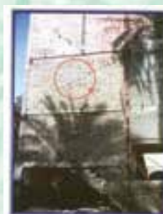
استفاده از مقاطع نامناسب در مهاربند ساختمان
