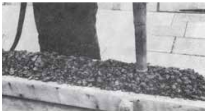
شکل ۶-۱۲- فرو بردن یک لرزانده میله‌ای در داخل بتن تازه در یک قالب تیر
