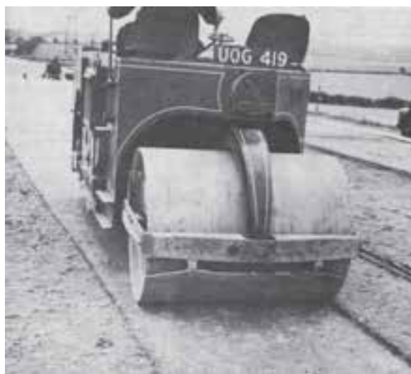
شکل ۶-۹- متراکم کردن بتن کم‌عیار با غلتک
