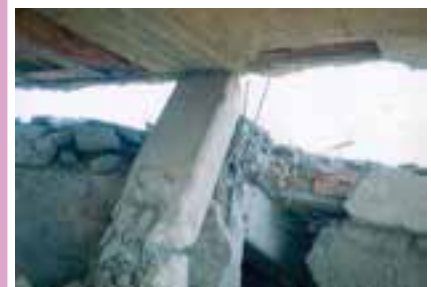
ضعف ستون و عدم اتصال صحیح به تیر بتنی موجب تخریب سازه شده است.
