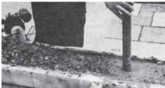
شکل ۶-۱۳- در نقاطی که بلافاصله نزدیک میله قرار گرفته‌اند، بتن کاملاً متراکم شده است. باید دقت کرد که سطح بتن در این نقاط چگونه پایین رفته است.
