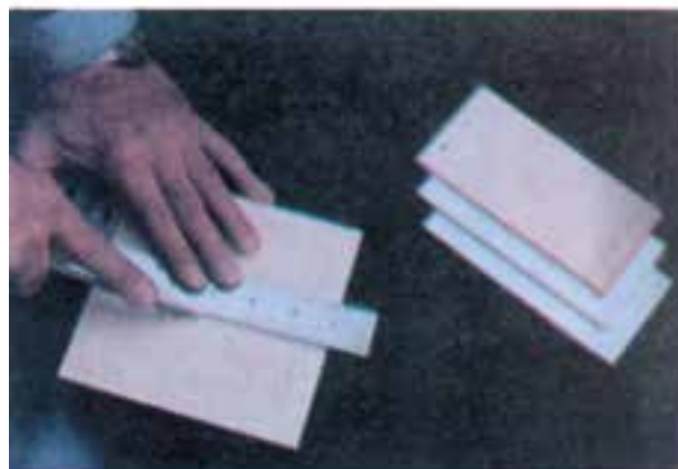
شکل ۱۲-۶- نحوه‌ی خط اندازی پشت کاشی جهت دو نیم کردن کاشی
