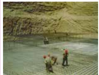
نمایی از یک فونداسیون گسترده (رادیه) مربوط به یک مجتمع مسکونی ۲۰ طبقه در حال آرماتوربندی
