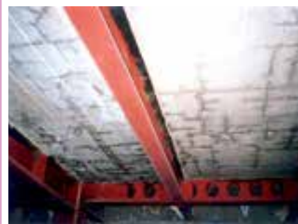
دال مرکب بتنی پس از بتن‌ریزی
