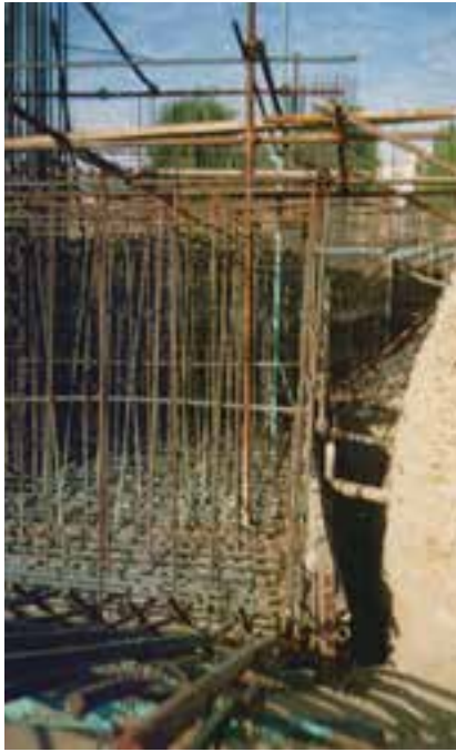
نمایی از خرک‌ها و میل‌گردهای یک فونداسیون گسترده
