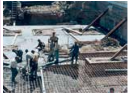
نمایی از فونداسیون نواری و مرکب از یک ساختمان مسکونی در حال بتن‌ریزی
