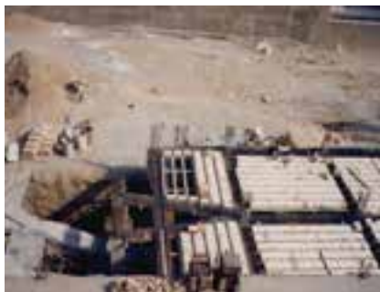
اجرای سقف تیرچه بلوک
