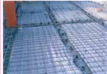
آرماتوربندی دال بتنی دو طرفه در یک سازه‌ی اسکلت فلزی (دال مرکب)
