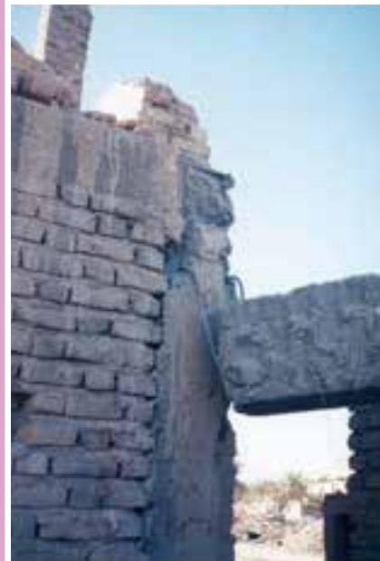
عدم رعایت طول مهار می مناسب در آرماتورهای فوقانی باعث شکست اتصال گردیده است.
