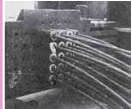
مهاری انتهایی کابل های پیش تنیده برای تیرهای حمل پل های بزرگ. در شکل ۲۰ کابل ۵/۰ اینچ نشان داده شده است.
