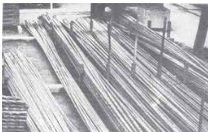
شکل ۸-۴- نحوه‌ی صحیح نگهداری میل‌گردها
