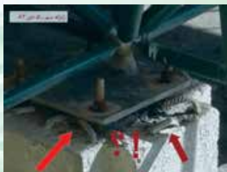
نمونه ای از اتصال نامناسب سازه به صفحه ستون در زلزله بم
