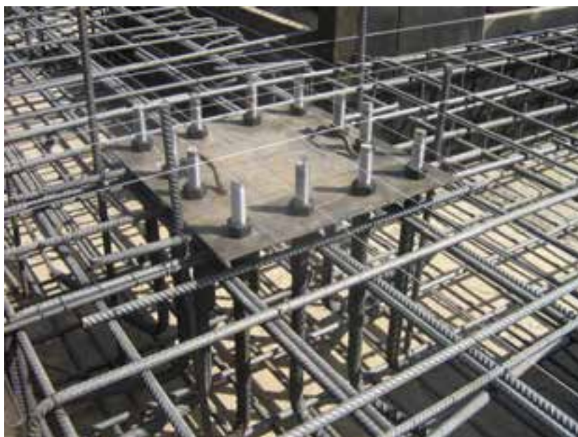
شکل ۳-۱۲- تنظیم پیچ‌های مهاری با شابلن و ریسمان
