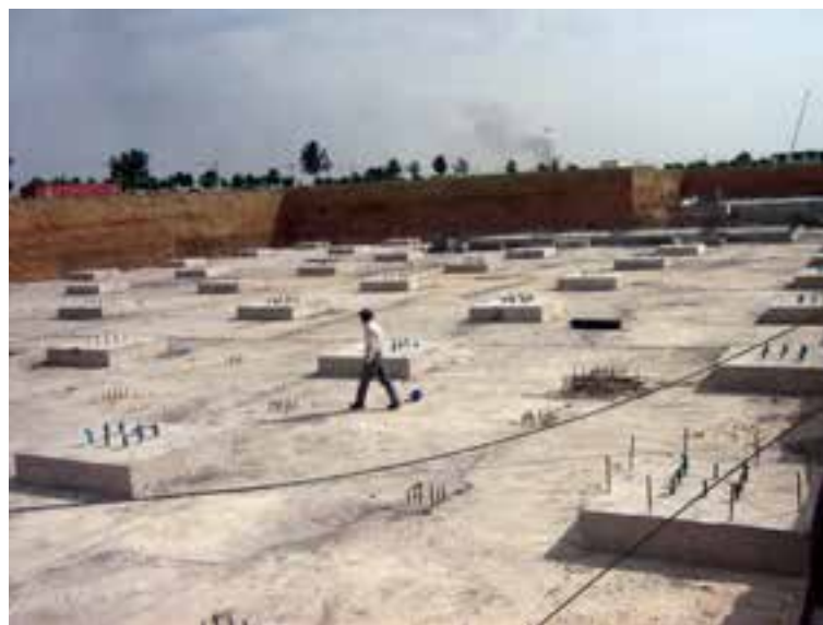
شکل ۷-۳ - شالوده‌ی گسترده و کتیبه‌های روی آن
