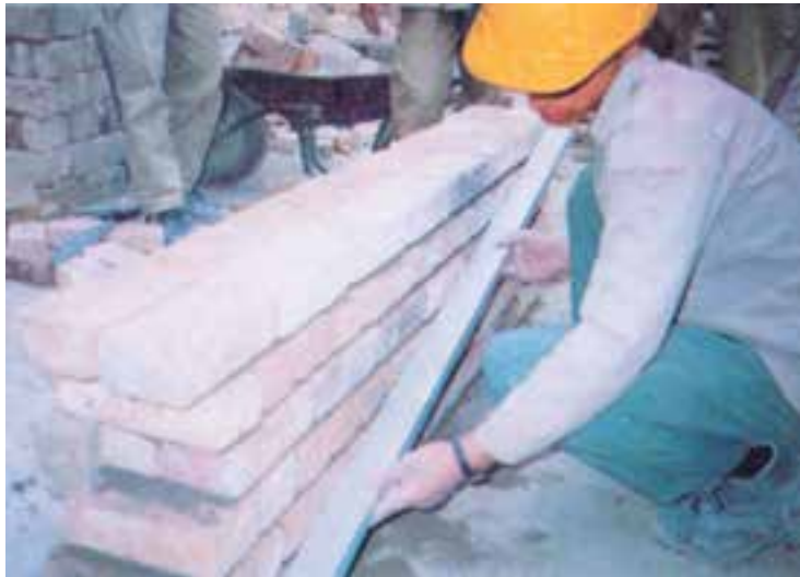
— مرحله‌ی اول طریقه‌ی ضربدری کنترل‌نما با شمشه (کنترل پیچیدگی نما)
