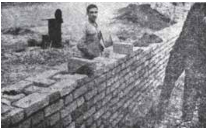
شکل ۵۱-۱- «نحوه‌ی بستن ریسمان با استفاده از وابند ریسمان»
