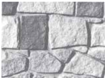
شکل ۱۱-۲- دیوار با سنگ چندوجهی سرتراش رجدار
