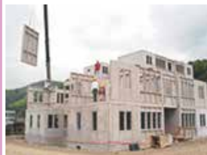
اجرای ساختمان پیش ساخته بتنی
