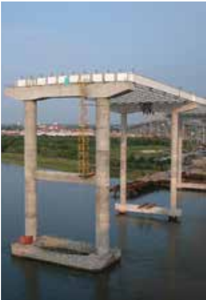
پایه‌های بتنی یک پل
