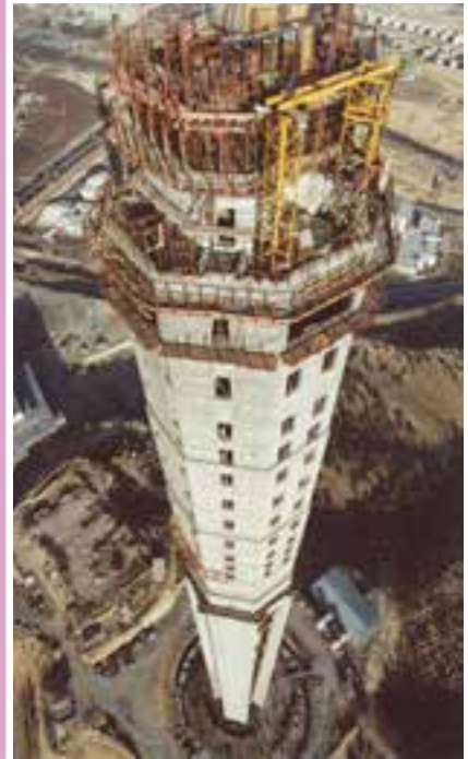
برج مخابراتی میلاد در حال ساخت
