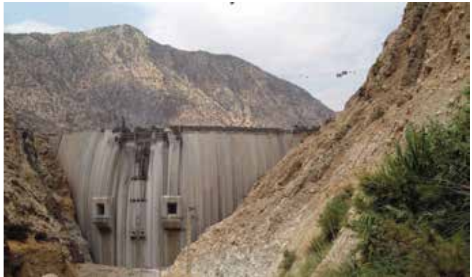
شکل ۱-۲- سد بتنی دو قوسی کارون ۳ که مرتفع ترین سد بتنی خاورمیانه است.
