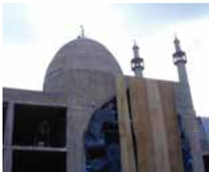
مسجد جامع شهر بم که پس از زلزله کاملاً سالم مانده است. اسکلت این بنا بتنی است.
