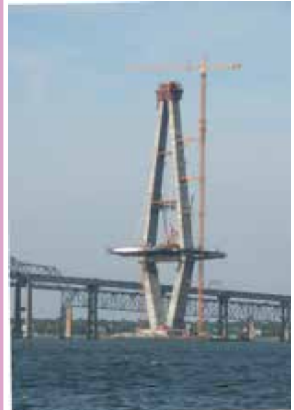
پایه بتنی یک پل کابلی
