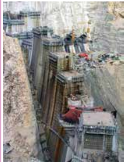
سد کارون ۳، در حال اجرای بدنه‌ی سد
