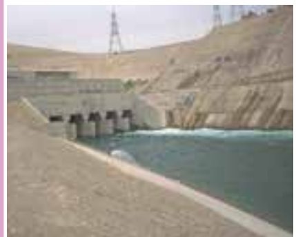
کانال بتنی آب
