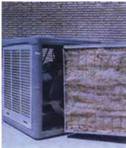
ب - ساختمان اطاقک یک کولر
