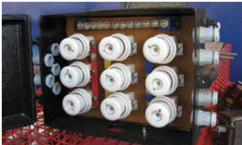
شکل ۷-۱ نمونه‌هایی از تابلوهای فیوز
